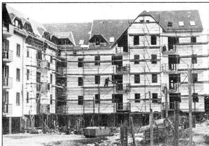
Állványerdőben a Zala Megyei Tanácsai Építőipari Vállalat Nagykanizsai Építésvezetősége által kivitelezett, még e hóban átadásra kerülő újabb 20 lakásos épület.
